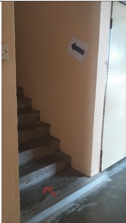
楼梯采单行道方式（高一诚旁为上楼楼梯）
