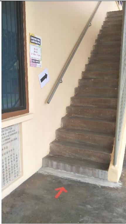
楼梯采单行道方式（上楼楼梯）
